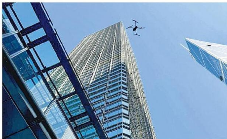
物業界現已採用無人機勘察外牆（圖），當發現問題可安排維修，毋須如傳統方法搭棚勘察，可節省時間，確保僱員安全。（受訪者提供）
